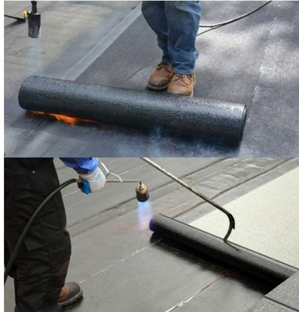
Foto 2: Un techador avanza un rollo de membrana.
