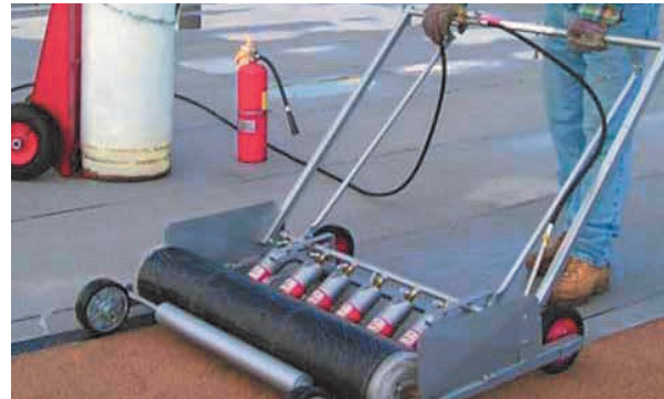
Foto 3: Un techador tira de un carro de soplete hacia atrás.
